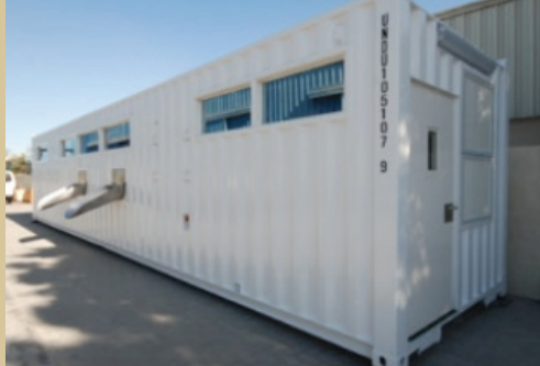
صورة (2) توضيح مدخل الطبيب والنوافذ ومخارج تصريف الجلود والأحشاء لخارج صالة الذبح في أحد المسالخ المتنقلة
