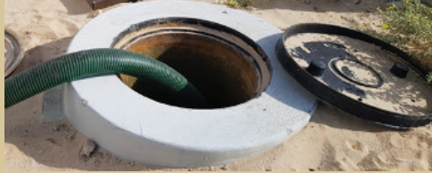
صورة (9) توضح طريقة التخلص من المخلفات السائلة
